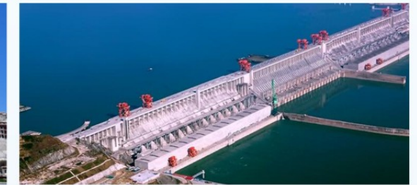
葛洲坝水利枢纽工程大坝
